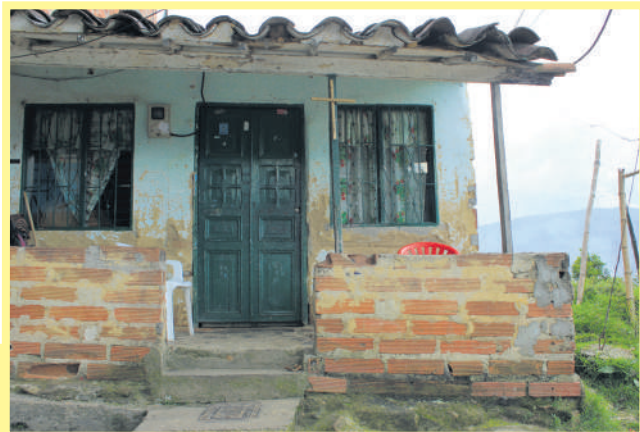
Es evidente el paso del tiempo. Existen edificaciones que tienen más de 50 años y en esta se observa el uso de material de bareque y ladrillo. Foto: Guillermo Velásquez
